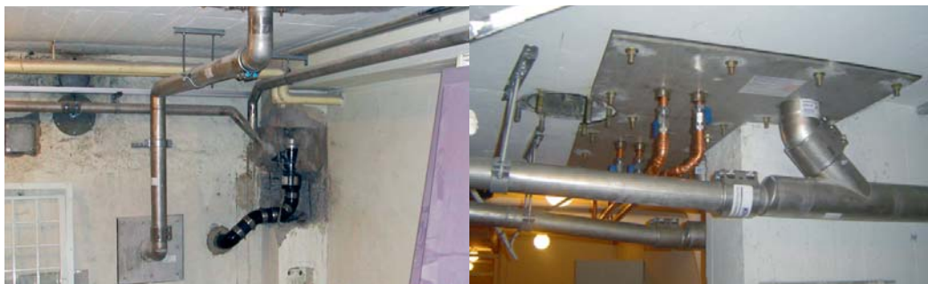
Bilderna visar godkända stammar i skyddsrum. Här är det specialplåtar, specialbultar och specialrör som gäller. Materialet ska vara syrafast och rostfritt. I en krigssituation måste allt hålla så att det inte läcker in till exempel stridsgaser i skyddsrummet.
